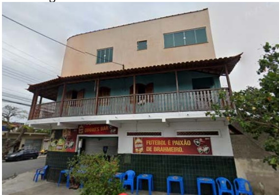
Figura 1 – Fachada do imóvel estudado
