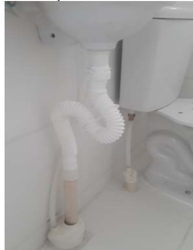
Figura 8 – Instalação do Lavatório e Bacia Sanitária
