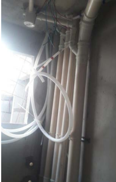
Figura 5 – Shaft de Hidráulica no Banheiro
