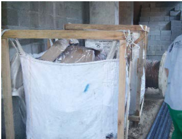
Figura 2 – Baías e tambores para acondicionamento dos resíduos
