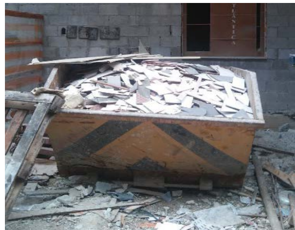
Figura 3 – Caçamba para recolhimento de resíduo Classe A
