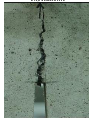
Figura 10 - Fissuração de uma viga com entalhe em um experimento
