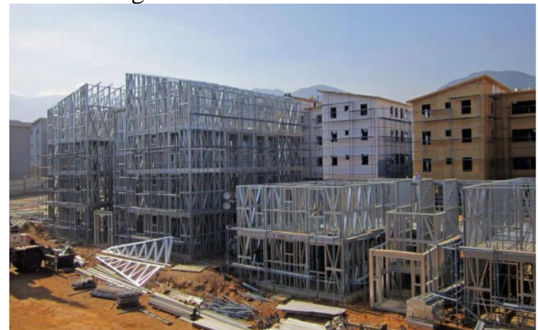
Figura 2. Steel frame estrutura
