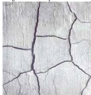
Figura 6 – Retração do Concreto
