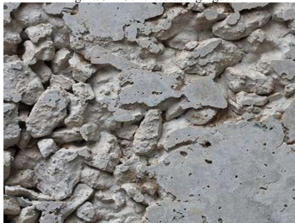
Figura 5 – Concreto desagregado
