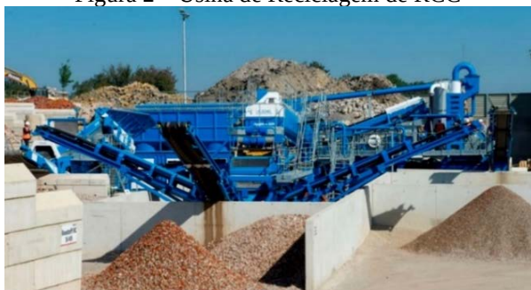
Figura 2 – Usina de Reciclagem de RCC
