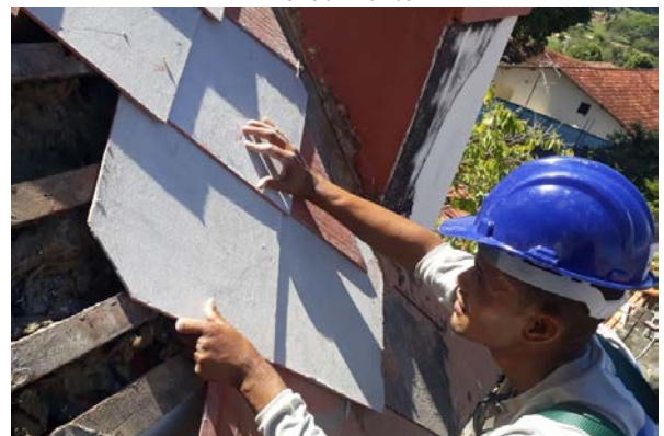
Figura 7 – Instalação manual das telhas de fibrocimento
