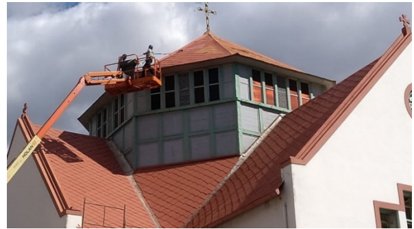
Figura 9 – Pintura do telhado
