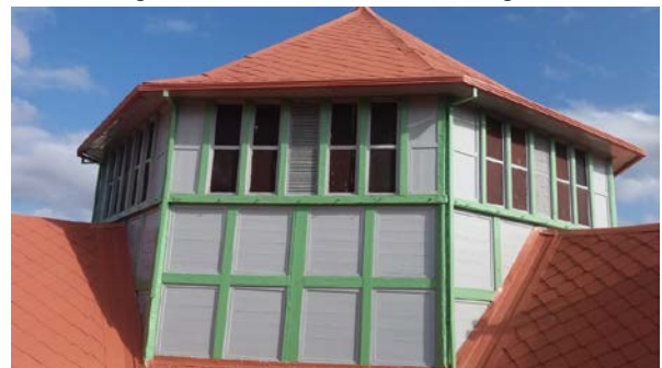
Figura 10 – Novas calhas no octógono
