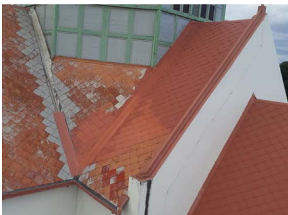
Figura 8 – Instalação de rufos e rincões
