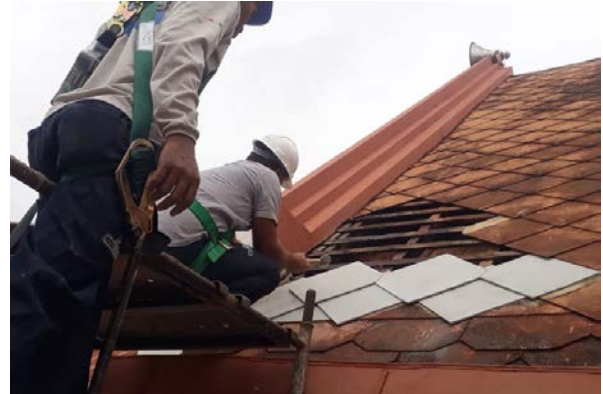
Figura 6 – Instalação das telhas com prego
