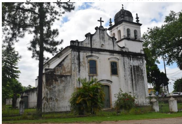
Figura 1: Igreja antes do início das obras.
