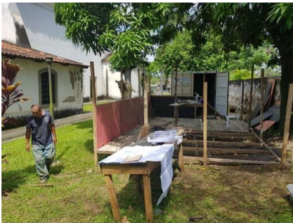
Figura 8 – Montagem de galpão para refeitório de funcionários no dia 31/01/2020.
