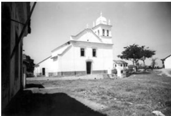
Figura 3: Fachada frontal e lateral
