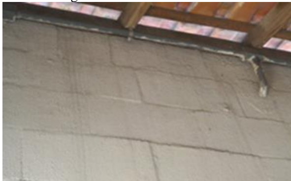
Figura 1 – Parede sem reboco.
