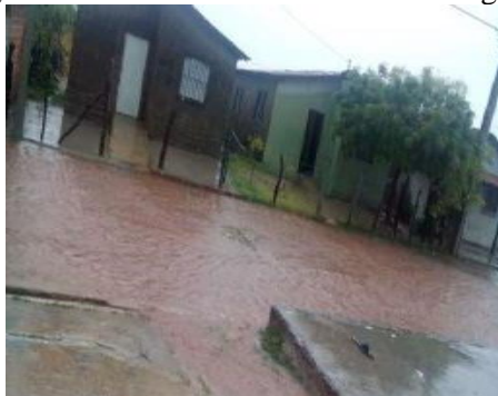
Figura 3 – Falta de um sistema de drenagem.
