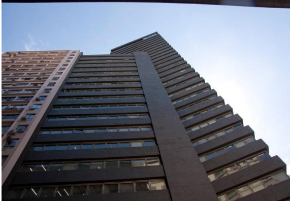
Figura 11: Edifício após a Recuperação Estrutural
