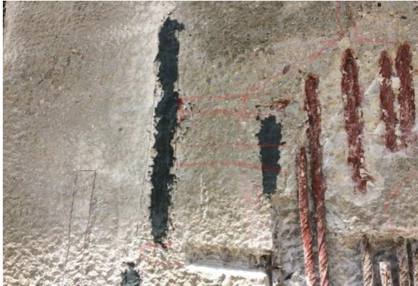
Figura 8: Ponte de aderência epoxídica.
