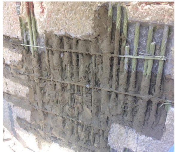
Figura 7: Inibidor de corrosão local
