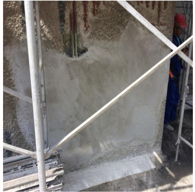
Figura 9: Argamassa polimérica aplicada.
