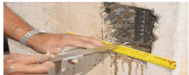
Figura 5: Medição do recobrimento da armadura
