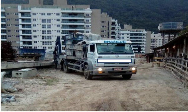
Figura 16. Processo de retirada de resíduos
