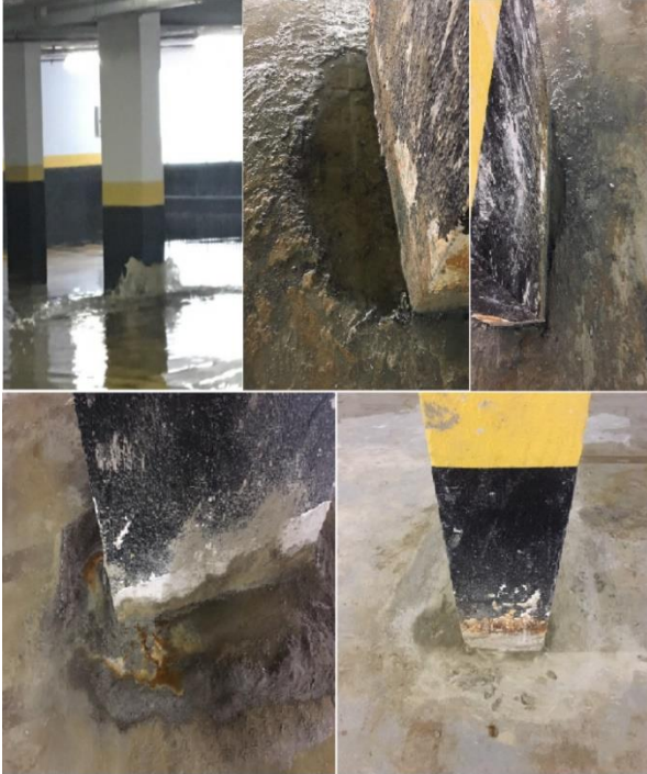
Figura 18 – Redução do vazamento até cessar
