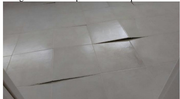
Figura 7: Piso em processo de deslocamento
