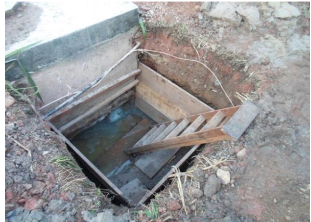
Figura 4 – Poço de Inspeção
