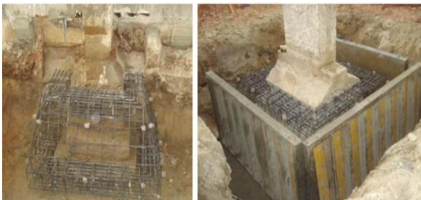
Figura 8 - Exemplo de execução do alargamento da sapata
