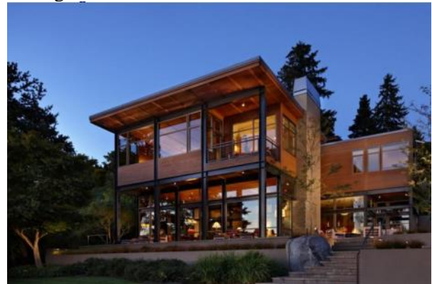
Figura 9: Casa construída com sistema LSF
