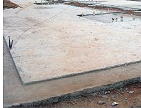
Figura 2: Exemplo de radier para LSF
