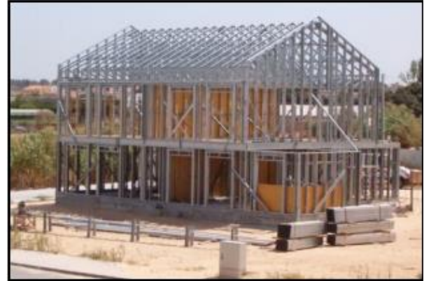
Figura 1: Estrutura em sistema LSF
