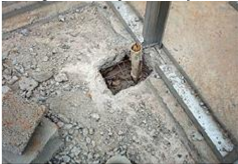
Figura 3: Furo para instalações
