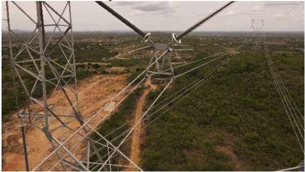
Figura 01 – furto de cabo condutor na fase B, na zona rural do município de Santa Bárbara, na Bahia.
