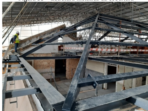
Figura 35 – Estrutura metálica da cobertura
