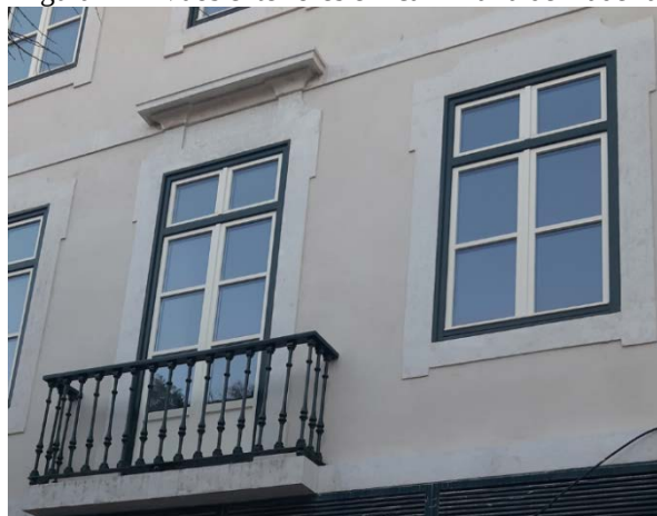
Figura 14 – Vãos exteriores em caixilharia de madeira
