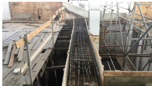
Figura 34 – Lintéis de coroamento para reforço das paredes
