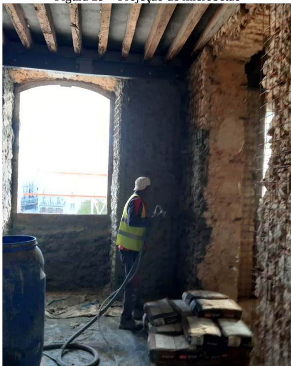
Figura 29 – Projeção de microbetão
