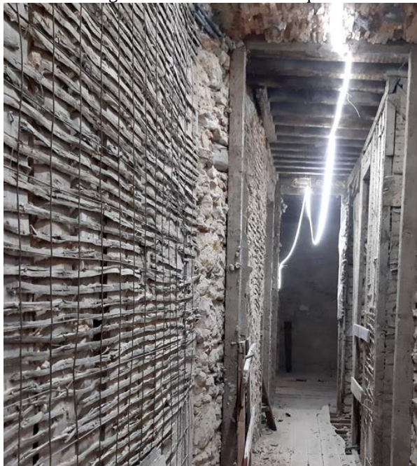
Figura 10 – Paredes em tabique
