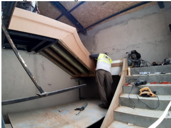
Figura 32 – Prolongamento da escada interior
