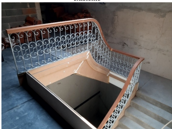
Figura 33 – Réplica da guarda metálica e do corrimão existente
