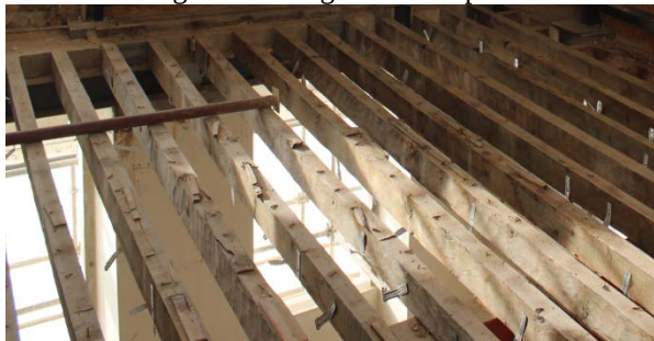
Figura 06 – Vigamento do piso
