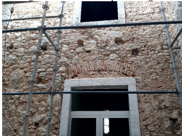
Figura 38 – Alvenarias em pedra do saguão
