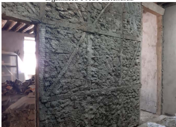
Figura 30 – Execução de reforço de parede frontal com argamassa e rede distendida
