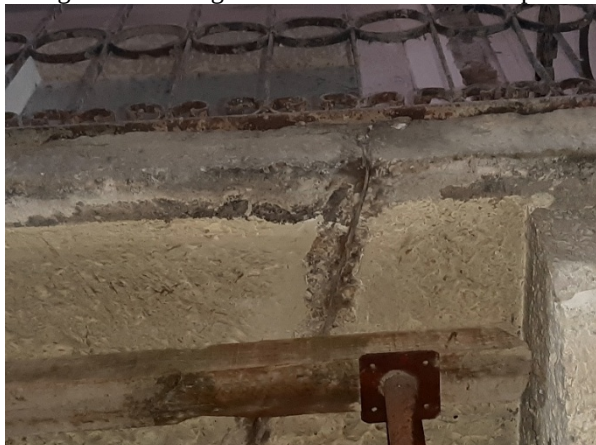
Figura 40 – Selagens de fissuras com resina époxi
