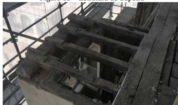
Figura 12 – Estrutura da trapeira
