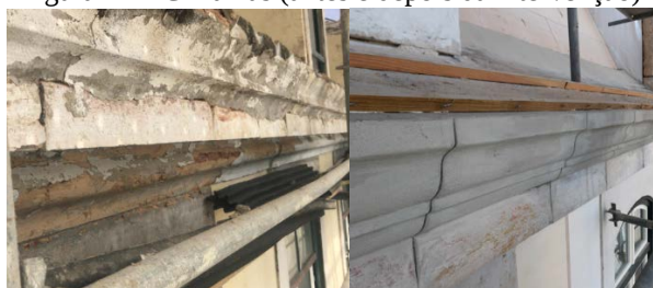
Figura 17 – Cimalthas (antes e depois da intervenção)
