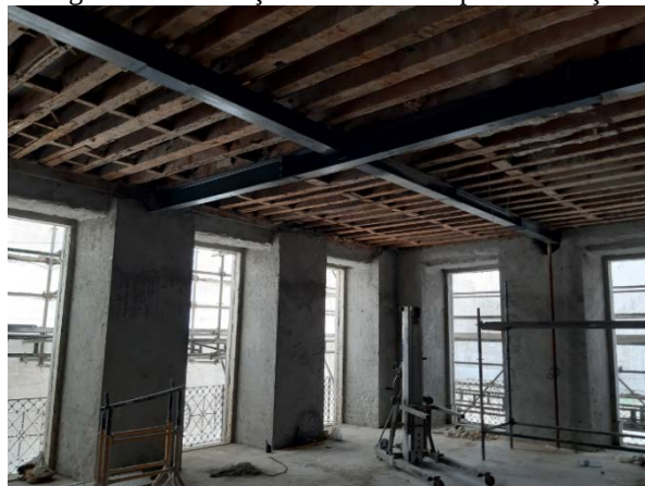
Figura 24 – Reforço estrutural com perfis em aço
