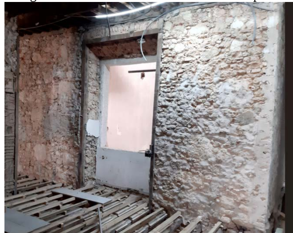
Figura 08 – Paredes exterior em alvenaria de pedra
