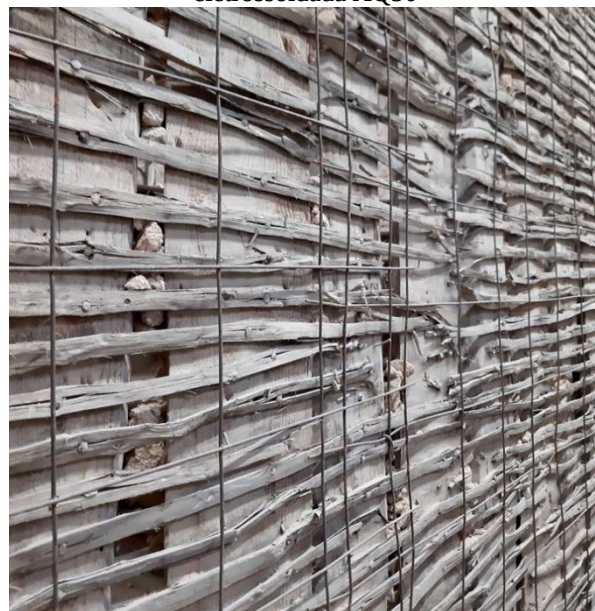
Figura 31 – Reforço da parede de tabique com malha eletrossoldada AQ50
