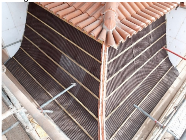
Figura 37 – Pormenor do telhado de mansarda
