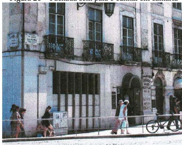
Figura 20 – Fachada sem pala e cunhal em cantaria
