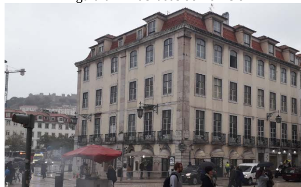
Figura 04 – Fachadas do Edifício
