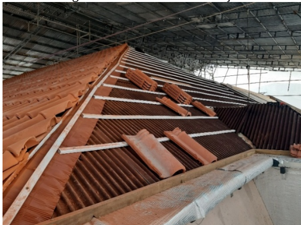
Figura 36 – Telhado em execução
