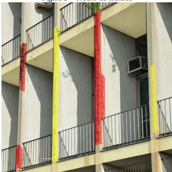
Figura 5 – Trecho da fachada
