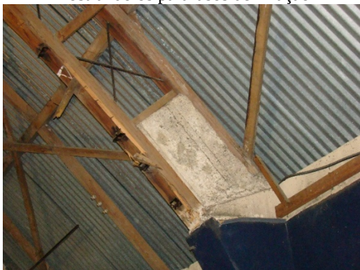
Figura 4 – Detalhe do apoio dos arcos em concreto, mostrando os parafusos de fixação
