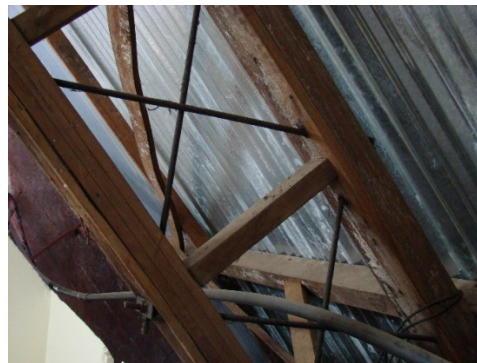
Figura 2 – Vista geral da cobertura, mostrando os arcos de madeira e as telhas metálicas
