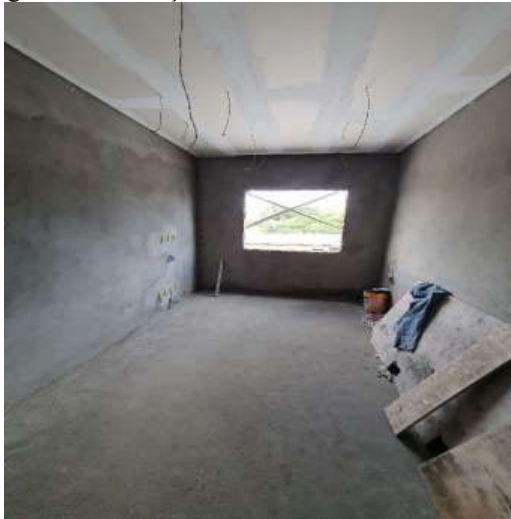
Figura 9 – Execução de reboco com aditivo colante.
