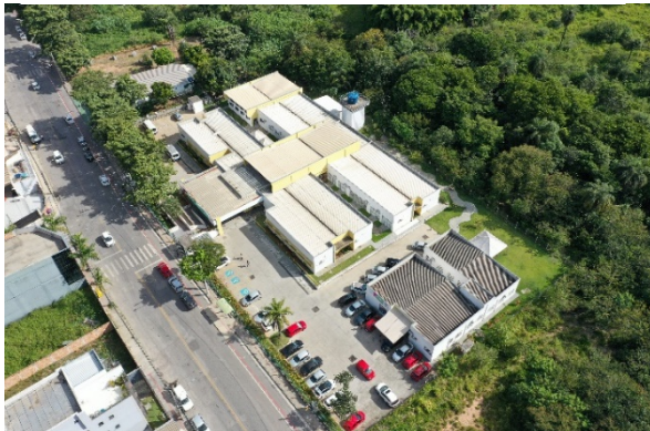
Figura 4 – Vista aérea CER IV Contagem
