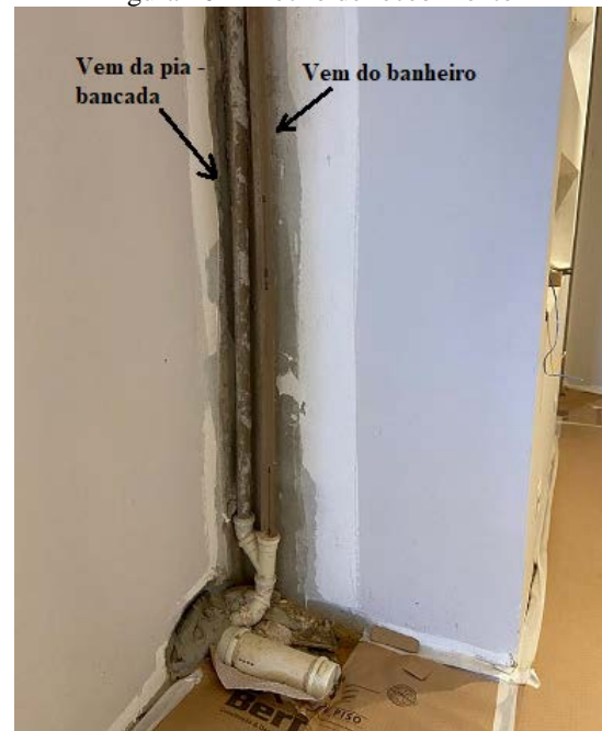
Figura 16 – Trecho de recebimento
