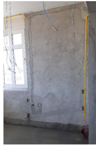
Figura 12 – Parede da nova bancada com pia
