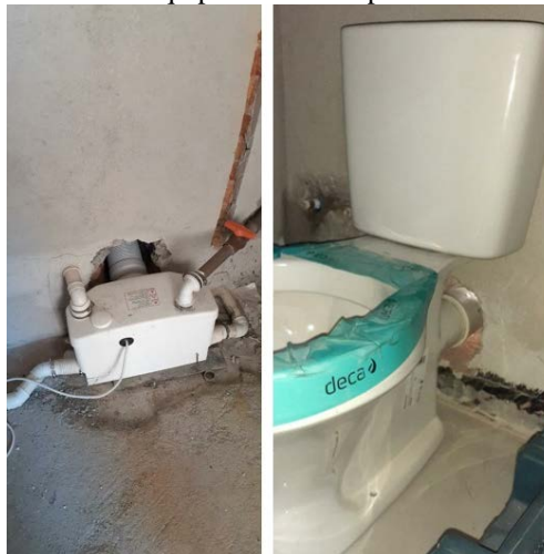
Figura 21 e 22 – Equipamento “sanipro” sem acabamento
