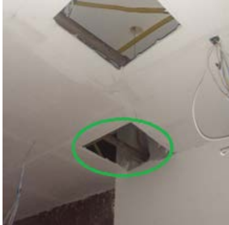
Figura 15 – Tubo de recalque sobre rebaixo
