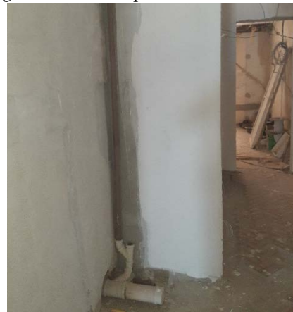
Figura 13 - Trecho primário de recebimento
