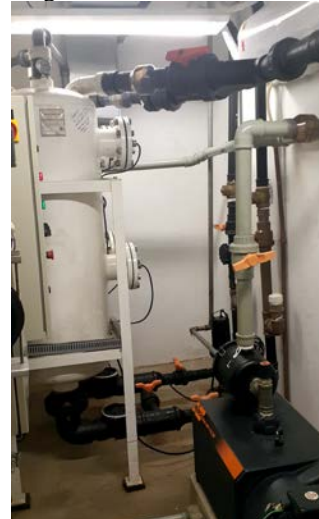
Figura 3 – Central de vácuo
