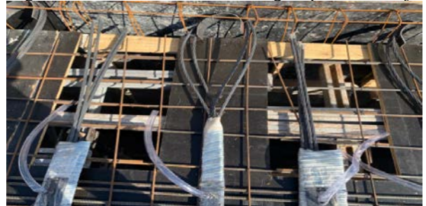
Figura 16: Detalhamento da ancoragem passiva na laje
