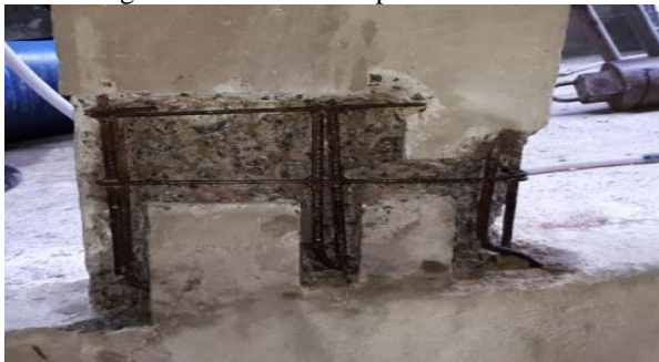
Figura 5: Armadura do pilar do subsolo.
