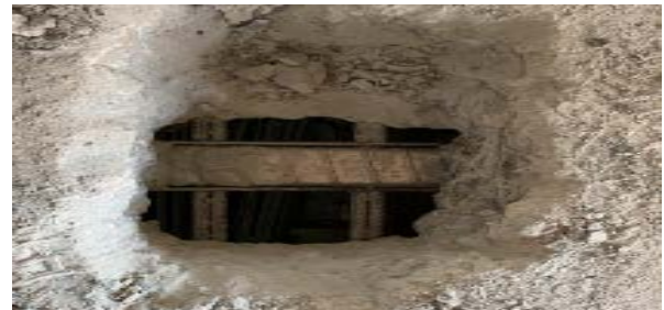
Figura 23: Detalhe de corte feito na laje para análise da bainha.
