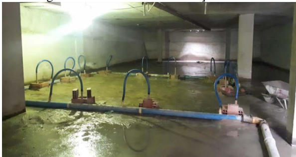
Figura 4: Rebaixamento do lençol freático.
