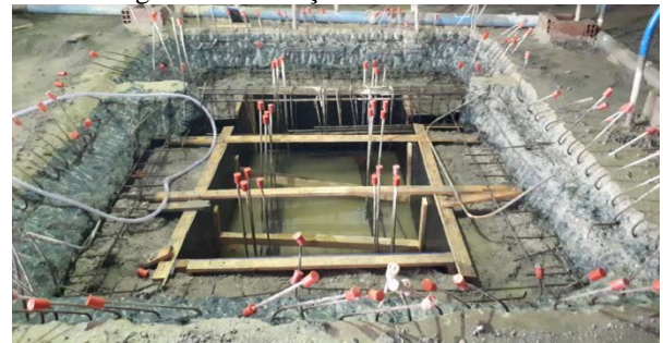
Figura 8: Escavação e forma do bloco.
