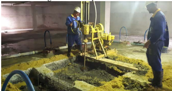
Figura 7: Execução da estaca Raiz.
