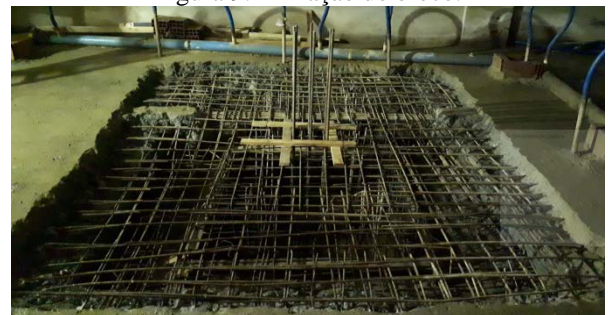
Figura 9: Armação do bloco.
