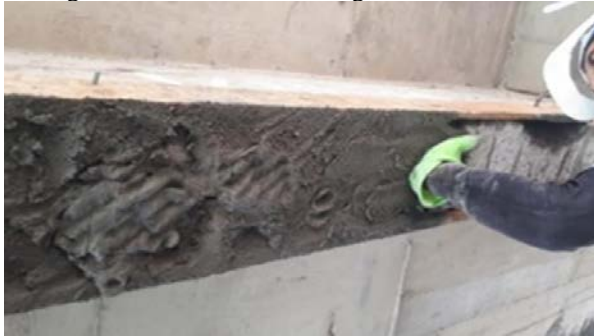
Figura 4: Tratamento com argamassa estrutural.
