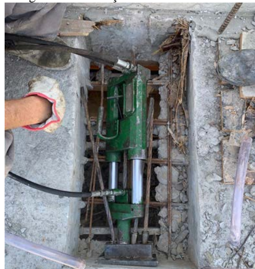
Figura 21: Execução da calda de cimento
