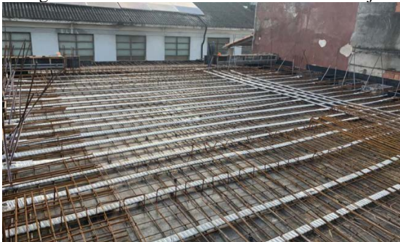
Figura 19: Detalhamento das cordoalhas na laje
