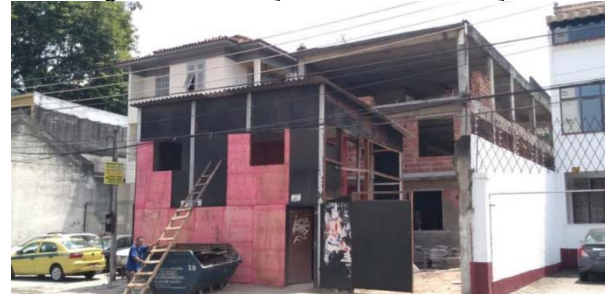
Figura 1: Construção antes da reabilitação
