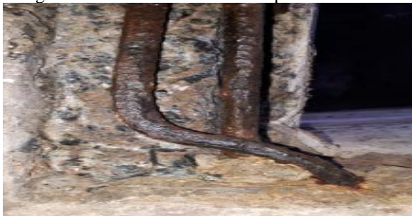
Figura 6: Detalhe da armadura do pilar do subsolo.
