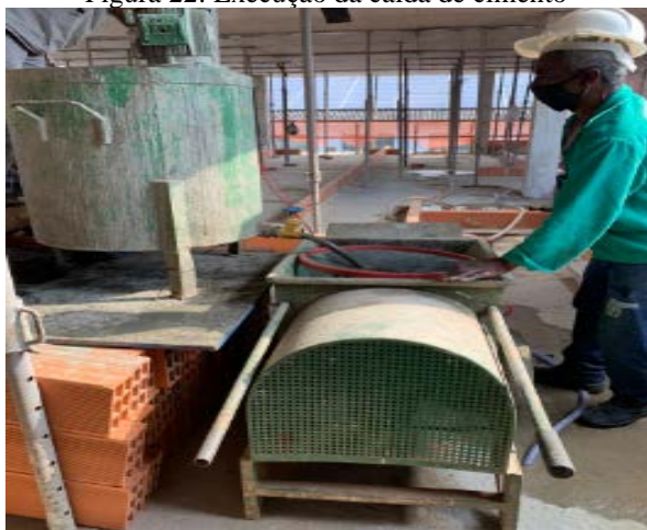
Figura 22: Execução da calda de cimento
