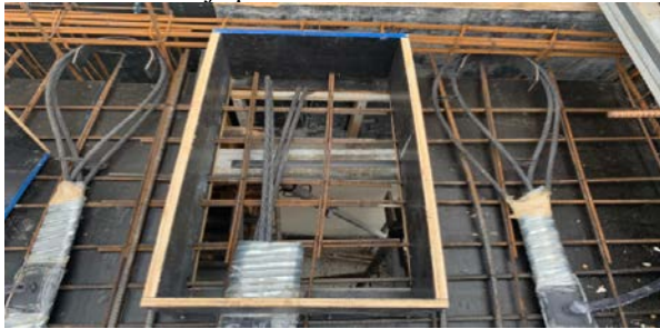
Figura 17: Detalhamento do nicho de ancoragem da laje para cordoalha ativa.
