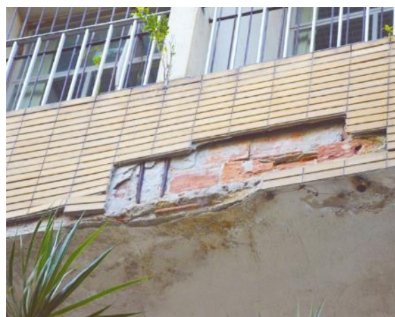
Figura 4 – Sintomas recorrentes: (a) perda de cobertura (Trecho 9); (b) deslocamento dos revestimentos cerâmicos (Trecho 11); (c) exposição, oxidação e rompimento das armaduras (Trecho 9) e; (d) flambagem das barras de aço (Trecho 9)
