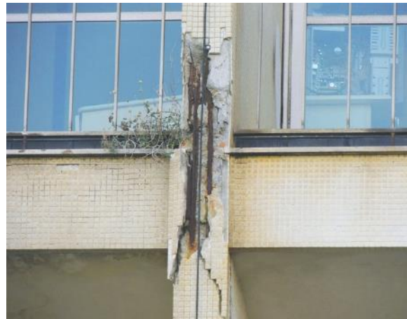
Figura 5 – Fissuração em função da expansão da seção da barra de aço: (a) Trecho 4 e; (b) Trecho 11
