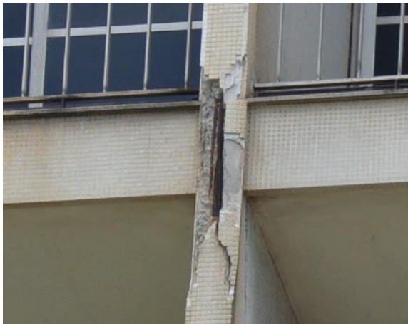
Figura 5 – Fissuração em função da expansão da seção da barra de aço: (a) Trecho 4 e; (b) Trecho 11
