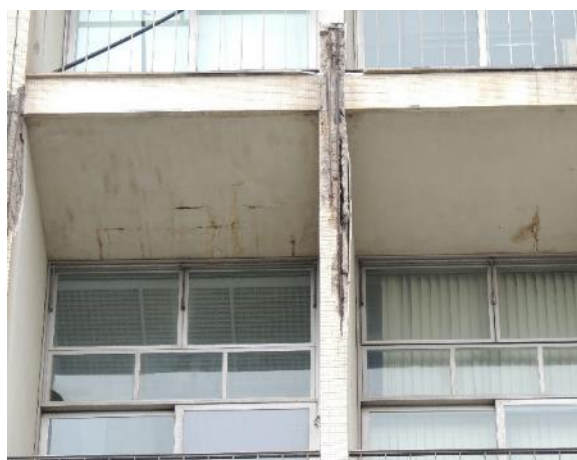
Figura 4 – Sintomas recorrentes: (a) perda de cobertura (Trecho 9); (b) deslocamento dos revestimentos cerâmicos (Trecho 11); (c) exposição, oxidação e rompimento das armaduras (Trecho 9) e; (d) flambagem das barras de aço (Trecho 9)
